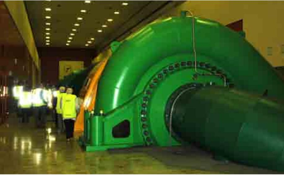
Im Kraftwerk 2 (Umwälzwerk) unter dem Stausee: eine der 4 Maschinen, die als Pumpen oder Generatoren benützt werden können.
