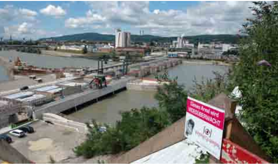
Das neue Rheinkraftwerk ist bald fertig gebaut (Blickrichtung gegen das deutsche Industrieareal).
