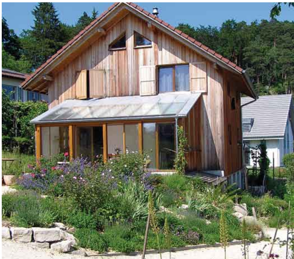
Die Süd-Westansicht des Ökohauses von Brunner und Hitz.
